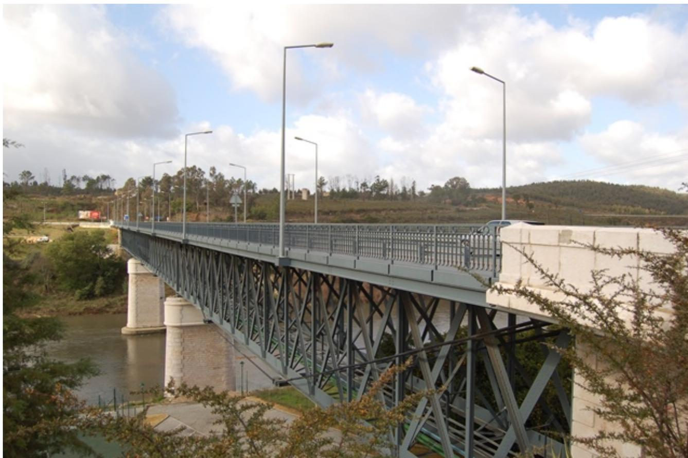
Construída em ferro sobre pilares de alvenaria, a ponte foi inaugurada em 1892 e veio resolver um antigo problema de Constância e dos concelhos vizinhos: a dificuldade de atravessar o Zêzere, que ainda não tinha barragens no seu curso e era muito impetuoso, em especial no inverno. A velha barca de passagem pôde então ser desativada.
